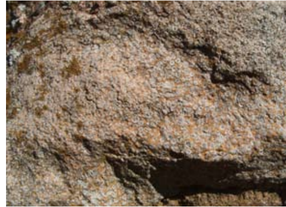
Rogenstein im Mauerwerk
